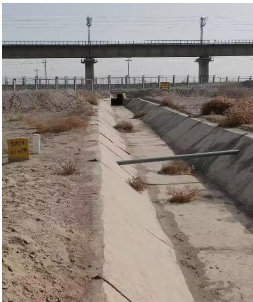
现场涵洞现场踏勘图
